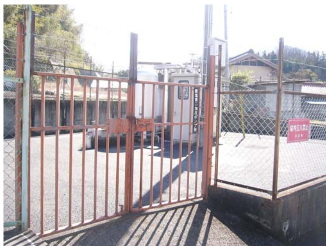
鹿塩第２ポンプ所
