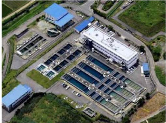
山之上浄水場
